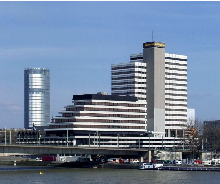
Neubau an der Deutzer Brücke (von-Gablenz-Str. – 1970–2007
